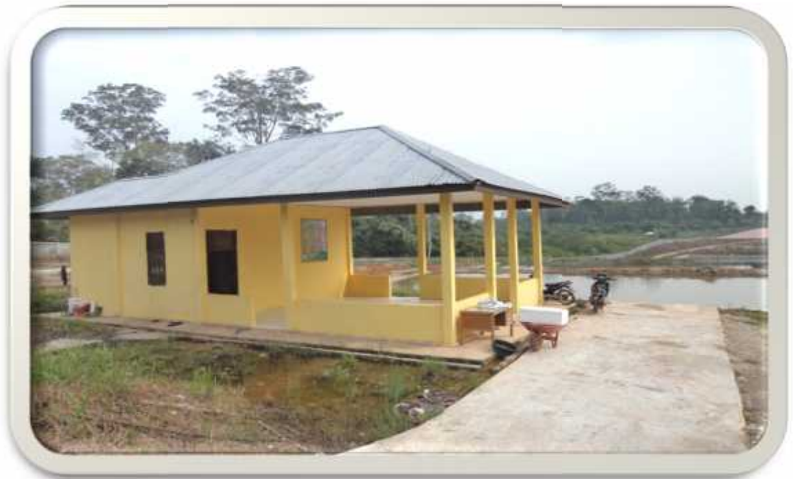
Gambar 11 : Rumah Jaga (dibangun tahun 2008)
