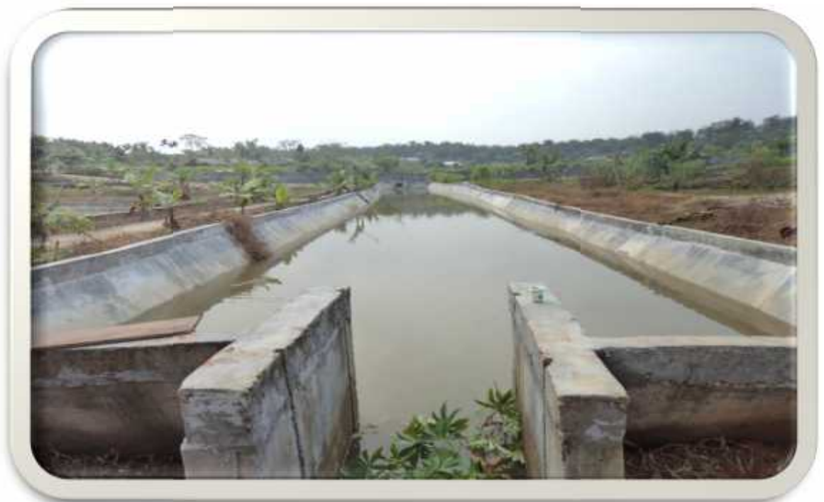
Gambar 12 : Saluran Pembuangan (dibangun tahun 2013)
