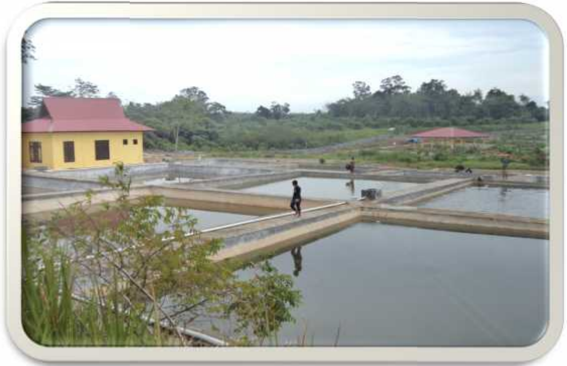
Gambar 5 : Kolam Induk (dibangun tahun 2013)
